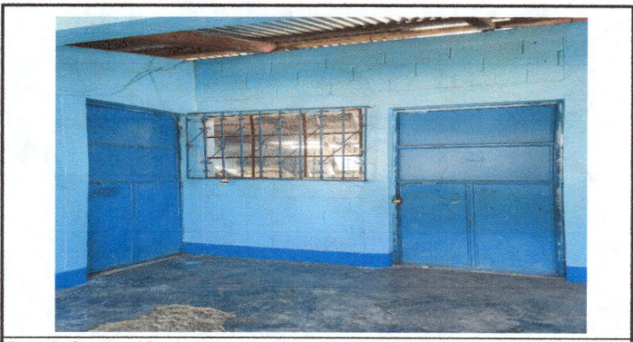
Foto 5: Sustitución de balcones de metal.
