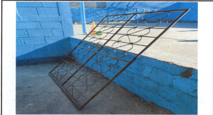
Foto1: Mantenimiento a barandas de metal.
