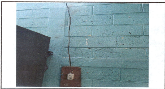
Foto 6: Sustitución de ducto electrico + accesorios.
